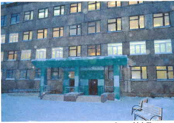
Фото №1 Территория прилегающая к зданию(участок)
